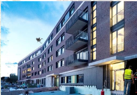
... Mehrgenerationenhaus in Karlsruhe Haid- und Neustraße
